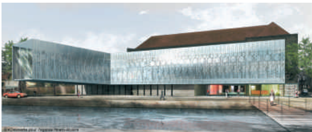
Le projet d'extension actuellement en cours du Musée de la Dentelle à Calais (par l'architecte A. Moatti)
